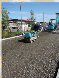
NS路盤は、現地で単粒度碎石・キョーリョクキープ under-砂を混合し、転圧して施工した路盤層です。
