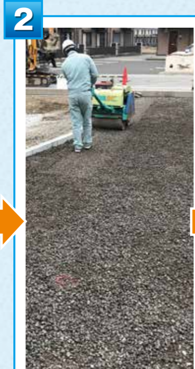
2 水締めを行いながら敷き均し、転圧する（200mm厚）。
