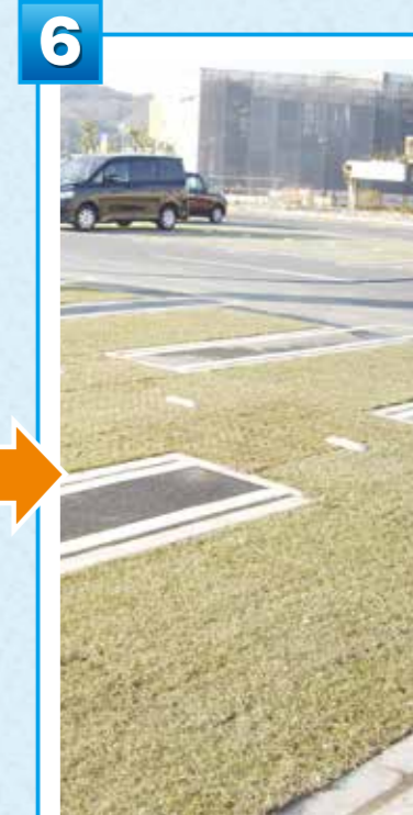
6 目土を散布し、完了。
