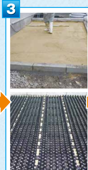
3 砂を敷き均し不陸整正する（25mm厚）。芝生保護材を並べる。 使用材料：砂・芝生保護材
