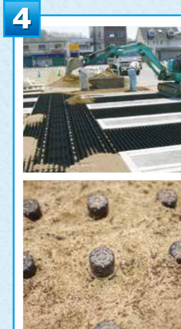
4 使用材料を均一に攪拌し、芝生保護材の突起が隠れない程度に敷き均す。 使用材料：グリーンフィルC・砂
