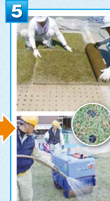
5 キョーリョクカー21を展開し、芝生保護材の頭が見えるまで転圧する。 使用材料：キョーリョクカー21
