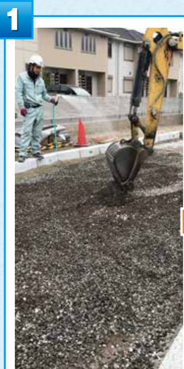
1 使用材料を均一に攪拌する。 使用材料：単粒度碎石4号・キョーリョクカーunder・砂
