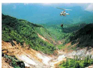
航空実播施工中
