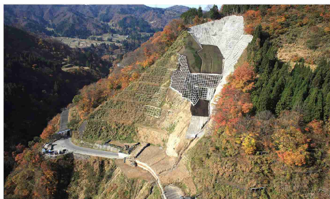
直高：130m / ホース延長：400m (新潟県災害復旧事例)
