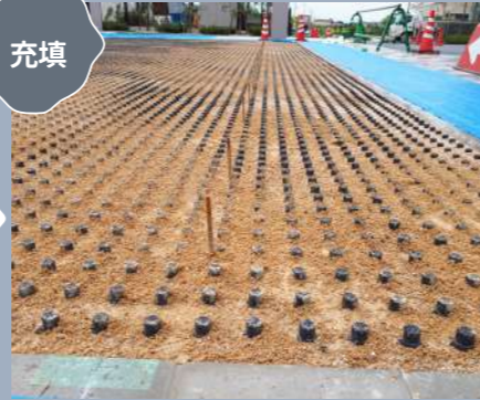
芝生保護材内に、砂とグリーンフィルCの混合物を充填する
