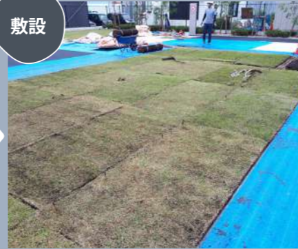
キョーリョッカー21 を敷き並べる
