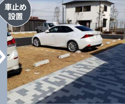
車止めや白線用部材を設置
