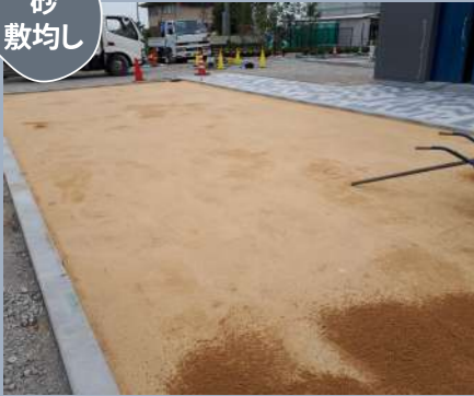
砂を敷き均し、55mm 下がりに仕上げる
