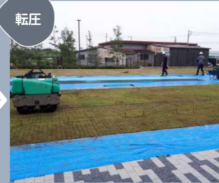
芝生保護材の突起が貫通するまで転圧する
