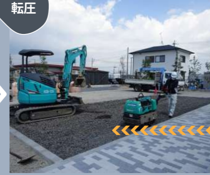
転圧し、80mm下がりに仕上げる
