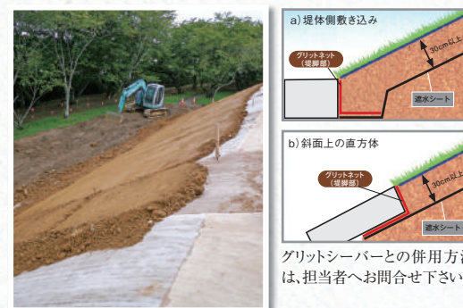
遮水シートと覆土の施工イメージ
