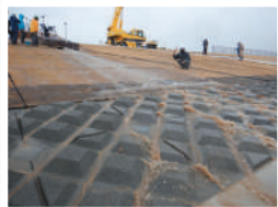
川裏のり尻保護工
