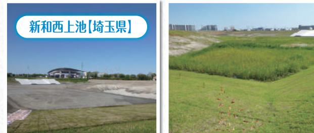
埼玉スタジアム付近を流れる綾瀬川の流量を調整する調整池のり面に施工。今後は公園整備も進められる見込みです。
