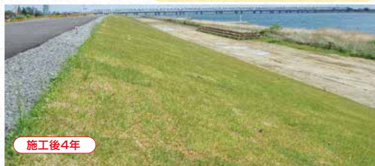
河川護岸での施工事例 (木曾川：愛知県)
