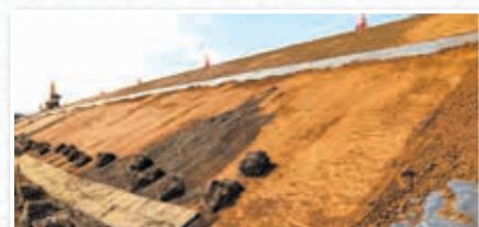
Bタイプに覆土し張芝を施工した例
