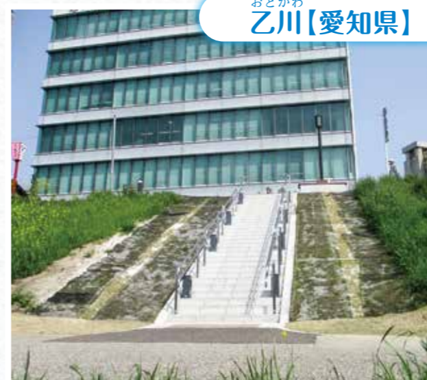
階段工両側の保護に使われた事例
