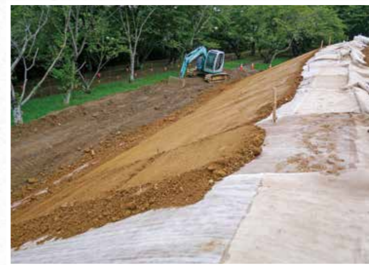
遮水シートと覆土の施工状況
