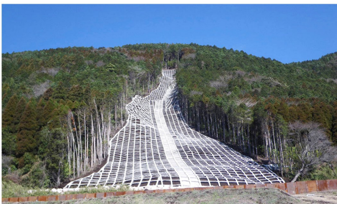
直高：220m / ホース延長：440m (熊本県災害復旧事例)
