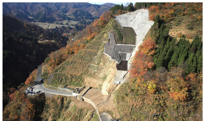
直高：130m / ホース延長：400m (新潟県災害復旧事例)
