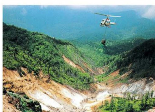
航空実播施工中
