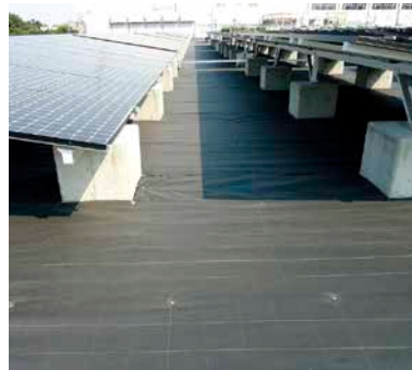
強力アグリシート施工例
