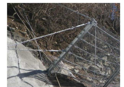
端末支柱への反力はサイドステーケーブルでサポートします。
