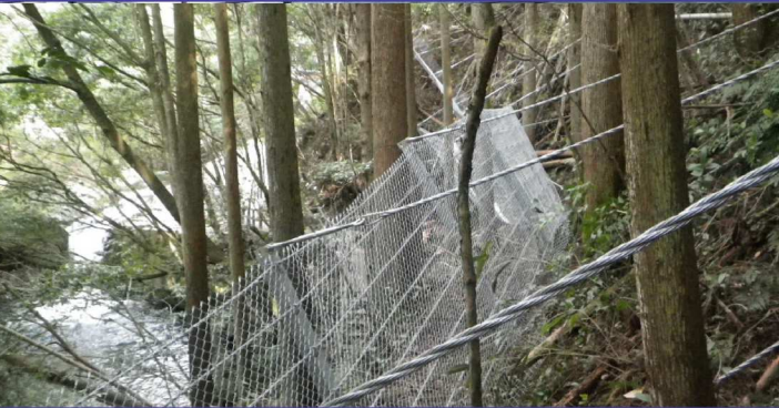
樹間施工が可能
