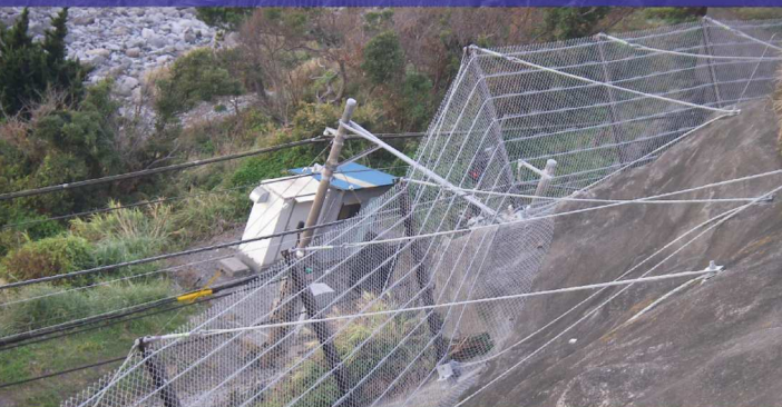
起伏に合わせて施工可能
