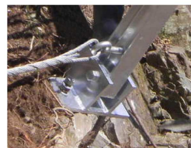
支柱の固定はポケット式落石防護柵と同様にアンカー基礎のヒンジ式。
