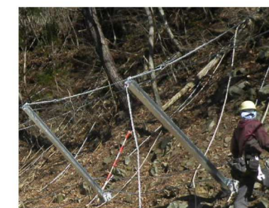
バックステーケーブルで支柱を固定するため、地山に対し垂直に支柱を設置できます。
