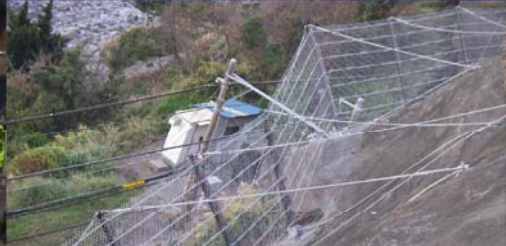
起伏に合わせて施工可能
