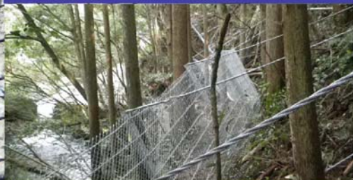
樹間施工が可能
