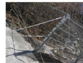
端支支柱への反力はサイドステーケーブルでサポートします。
