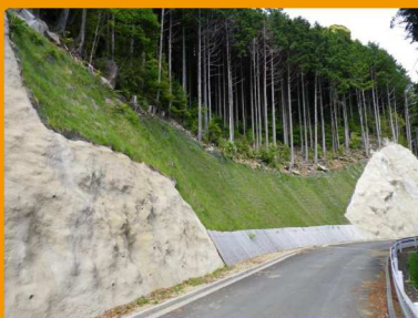
林道開設工事
