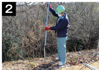
上部支柱のはめ込み
