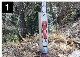
基礎支柱の打込み
