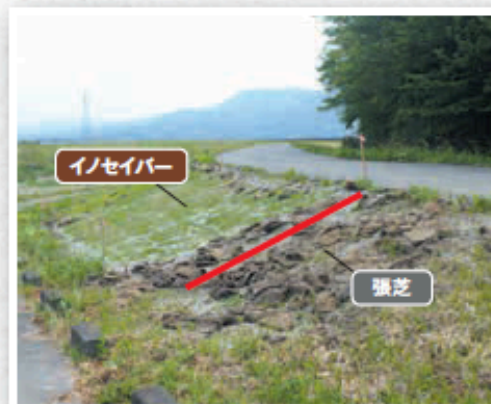
イノセイバーの周囲に施工した張芝だけがめくられている(岩手県衣川)
