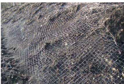
植生基材吹付工
