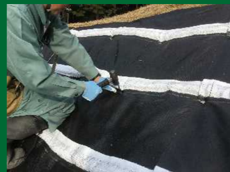
② アンカーピン打設
