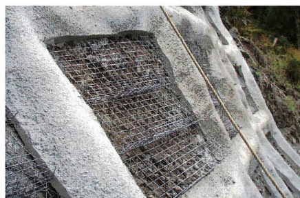
勾配緩和網設置完了
