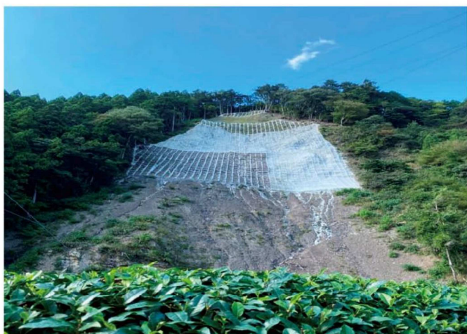
直高：100m / ホース延長：350m(静岡県)
