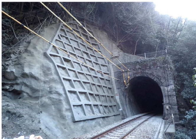
直高：-70m / ホース延長：300m(徳島県)
