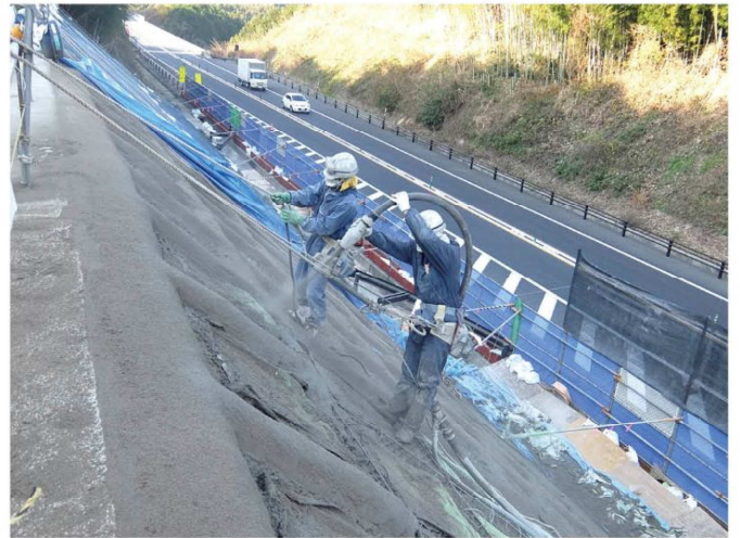
施工状況（鳥取県）
